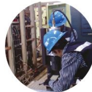
Instalación maniobras y montaje de equipos
